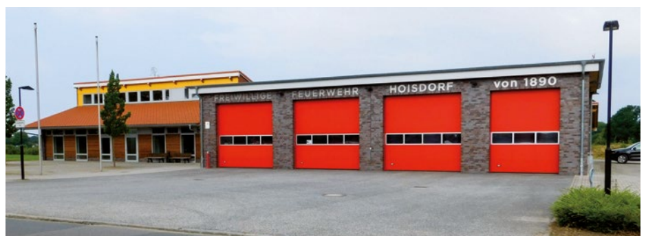
Geräumig: Viel Platz für die Einsatzkräfte im 2015 errichteten Feuerwehrhaus.
