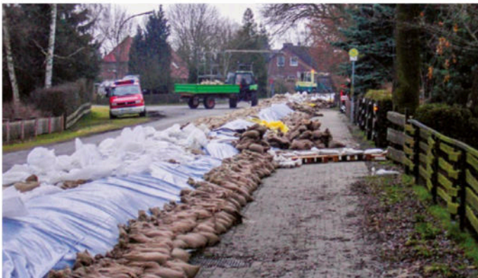
Provisorischer Damm in Bleckede beim Hochwasser 2006: Auf mehreren hundert Metern wurden solche Dämme errichtet. Neben dem geschütteten Damm waren enorme Mengen an Sandsäcken erforderlich.
