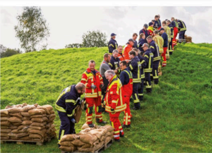
Kettenbildung: Transport von Sandsäcken auf den Deich.
