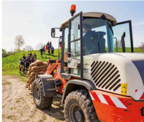
Unterstützung: Der Radlader wird vom Bauhof der Stadt zur Verfügung gestellt. Mitarbeiter des Bauhofs sind auch Teil des Ausbilderteams.
