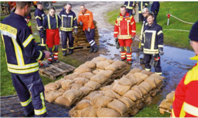
Abschlussübung mit „fließendem Wasser“: Deichfußsicherung mit Gittermatte, Geotextil und Sandsäcken. Das Wasser muss abfließen, der Deich wird so stabilisiert.
