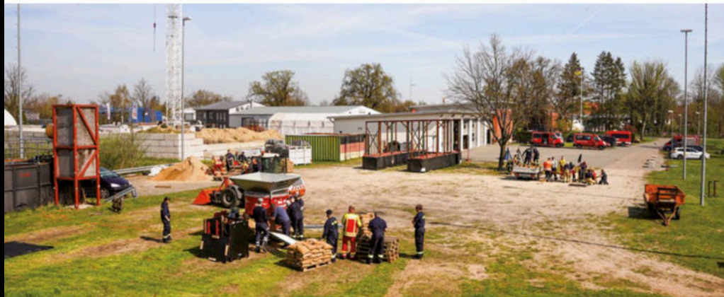
Blick vom Übungsdeich: Verschiedene Stationen zur Sandsackfüllung auf dem Übungsgelände mit Sandsackfüllmaschine, improvisiert und vom Anhänger.
