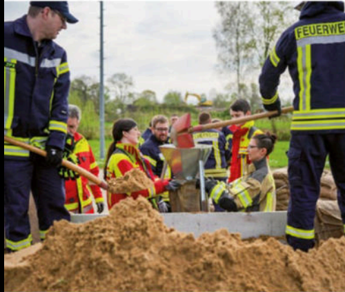
Sandsackfüllung: Diese dürfen nur zu etwa zwei Drittel gefüllt werden, damit sie gut verschleißbar und stapelbar sind.
